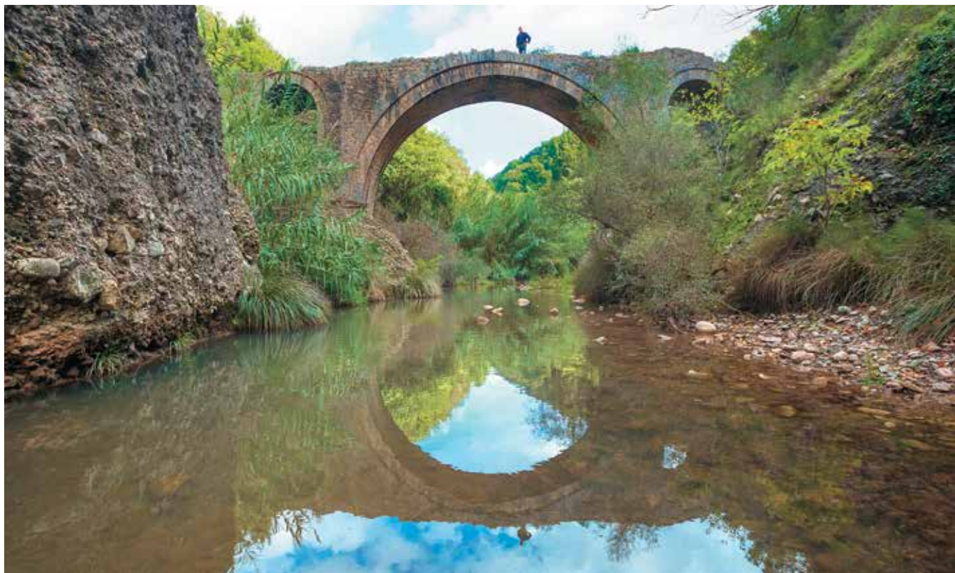
Το γεφύρι του «Χατζή» ή «Κακή Σουμάνη» βρίσκεται 3 κμ από το χωριό Αλιμάκι. Είναι μονότοξο με δύο μικρές καμάρες, έχει μήκος καταστρώματος 28,30 και ύψος 10,00 μέτρα. // The bridge of Chatzis or Kaki Soumani is located 3 km away from Alimaki village. It has one arch with two small spans, is 28.30 meters long and 10.00 meters high.
