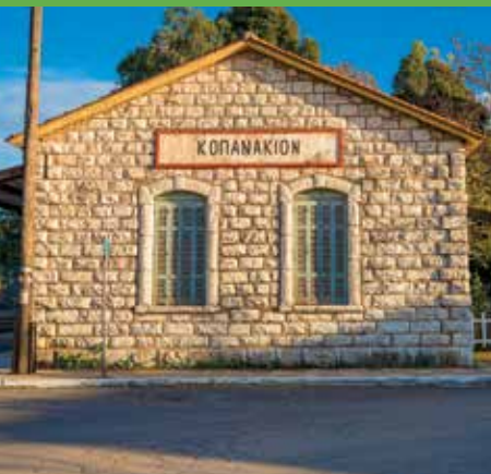
Το πέτρινο κτίριο του σιδηροδρομικού σταθμού. The stone building of the railway station.
