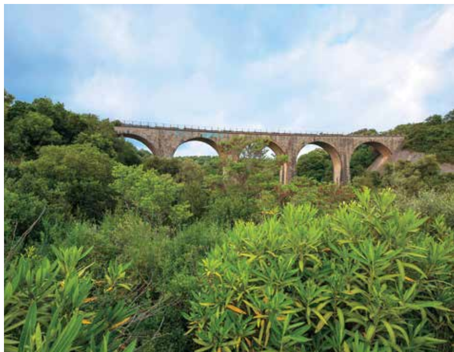
Λίθινη τοξωτή σιδηροδρομική γέφυρα μεταξύ των χωριών Καλό Νερό και Κοπανάκι. Arched stone rail bridge between the villages of Kalo Nero and Kopanaki.
